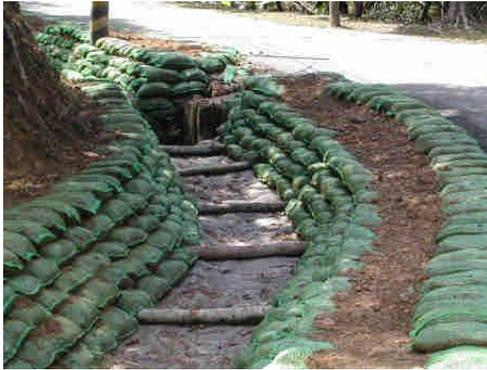
圖 7c 坡趾掘溝排水 (5)
