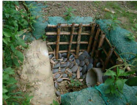
圖 7b 採用自然資材設計之疊水工 (5)
