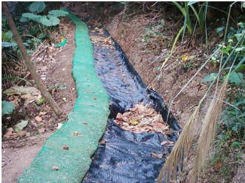
圖 7a 邊坡坡頂回填透水材料截水 (5)
