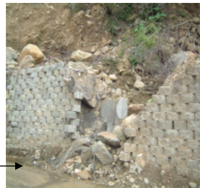
圖 12 GIS 點資料超連結勘災照片－ 加勁擋土牆
